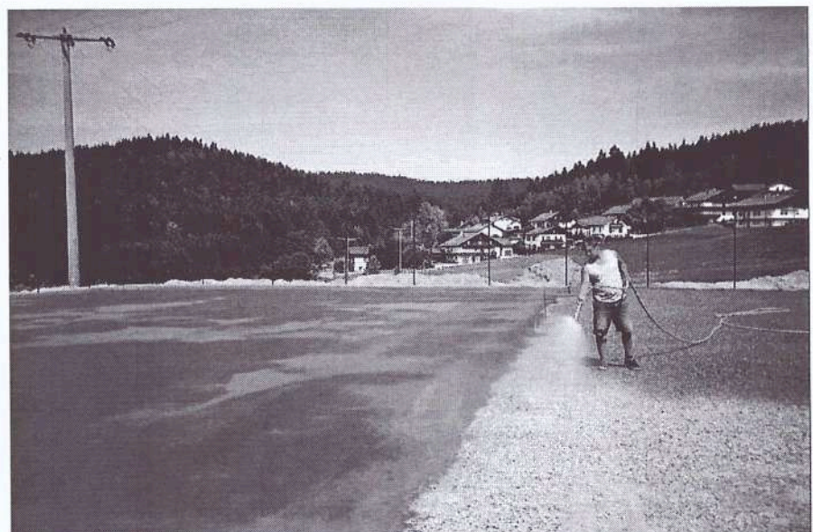
Ein Tennisplatz nimmt Gestalt an
